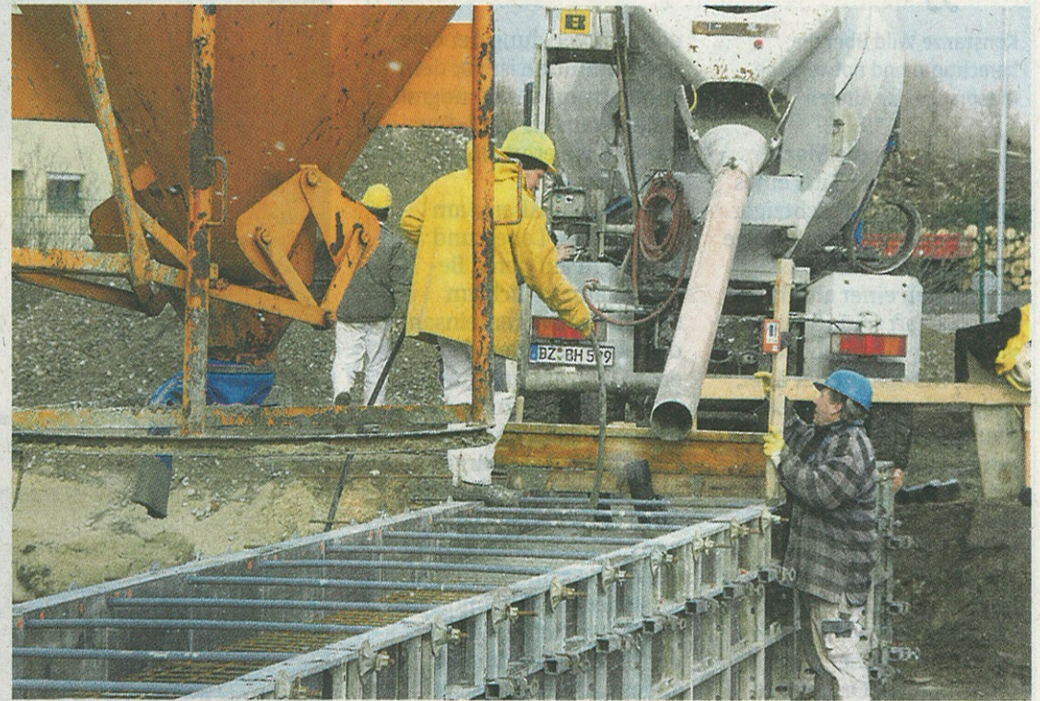
Eine neue Fertigungshalle für Elektromotore entsteht gegenwärtig in den Havelauen Werder.
